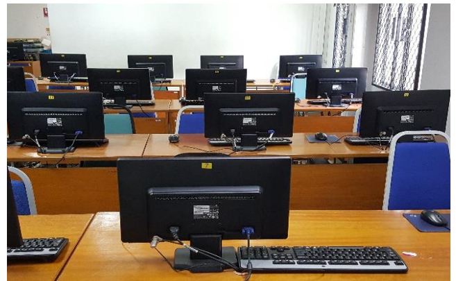
Pendawaian/kabel yang kemas dan selamat
