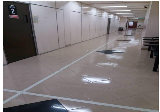
Lantai yang bersih, selamat dan tidak rosak
